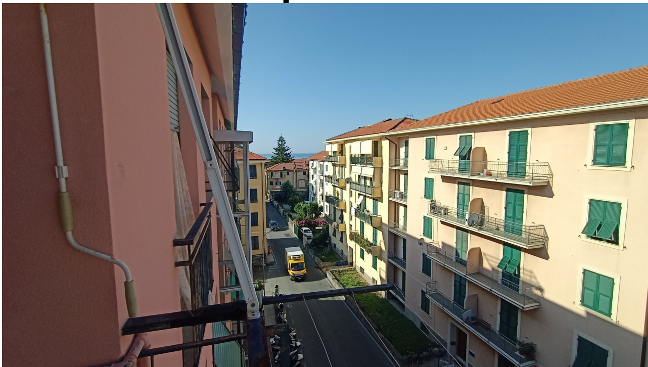
Foto 10 – VISTA-AFFACCIO LATO SUD
